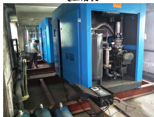
2台 55kW 永磁电机及变频功能的节能螺杆空气压缩机
