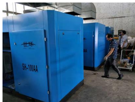
3台 75kW 永磁电机及变频功能的节能螺杆空气压缩机
