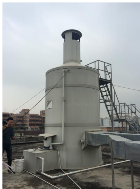
废气处理设备的外观
