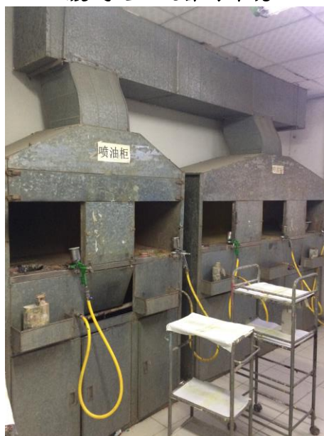
喷漆工序废气收集系统
