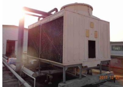
冷水机冷却水塔 (所有注塑机共用)
