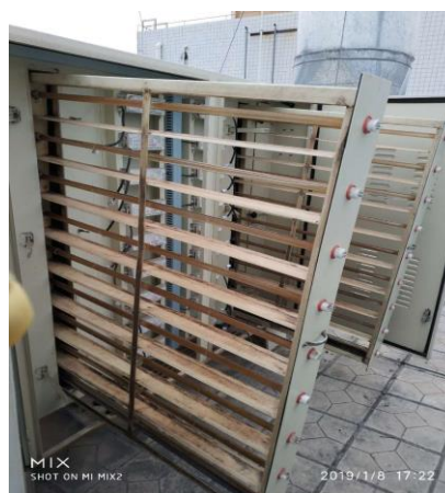
紫外线灯、氧化钛金属片层(媒板)
