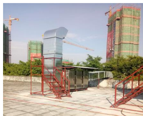
废气处理系统
