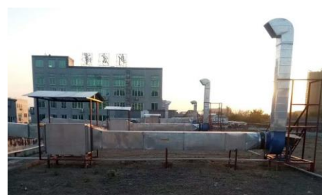
废气处理系统
