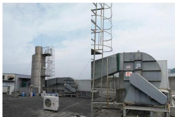
左: 化学洗涤有机废气净化系统
