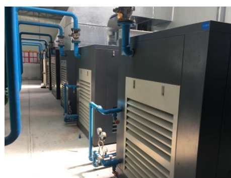
中央控制压缩空气的空压机组
