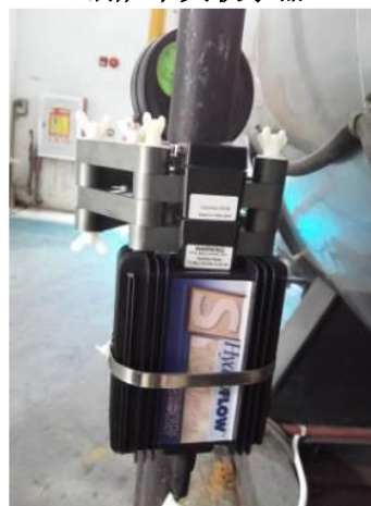
电磁波技术装置安装
