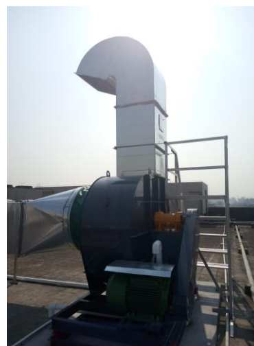
经处理后废气的排风口
