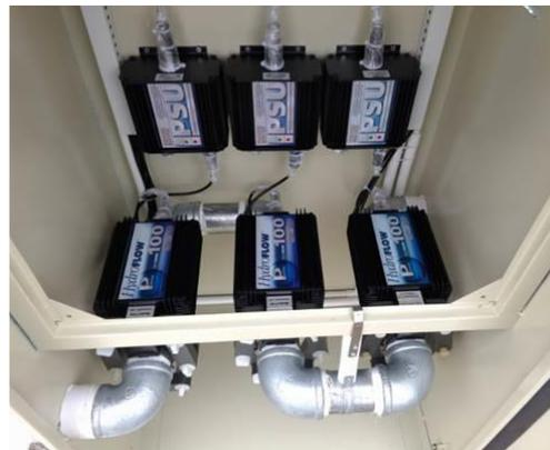
冷却水塔安装电磁波技术
