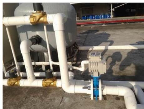
反冲洗式砂缸及出入水管道
