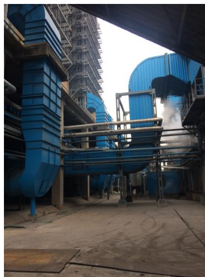
选择性非催化还原法脱硝系统管道外观
