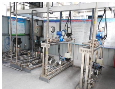
选择性非催化还原法脱硝系统安装情况
