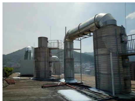
化学洗涤有机废气净化系统
