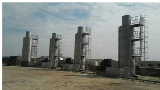
化学洗涤有机废气净化系统的外观
