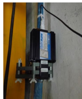
电磁波技术装置安装
