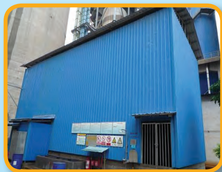
氨水罐儲存區
