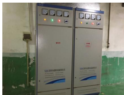
中央控制壓縮空氣的空壓機組
