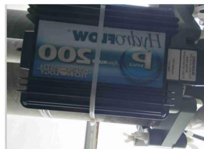
電磁波冷水塔水垢清除處理器
