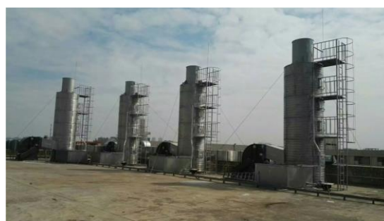
化學洗滌有機廢氣淨化系統的外觀
