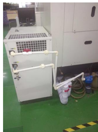
原有的獨立冷卻系統
