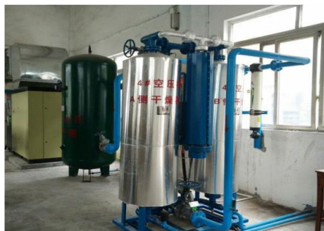
節能螺桿空氣壓縮機安裝情況
