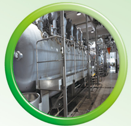
現場高溫染色機表面塗上節能保溫塗層後
