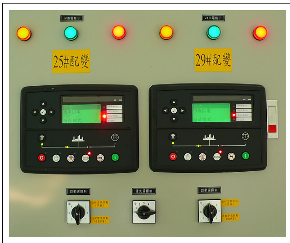
相 2.4 《電控系統》的操作屏及操作開關
